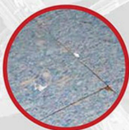
pavimenti in vinile
